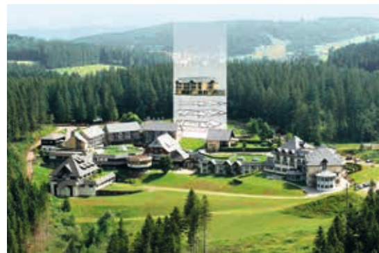
Die bundesweit anerkannte Rehaklinik Katharinenhöhe in Schönwald bekommt einen Anbau u. a. mit barrierefreien Patientenwohnungen.
