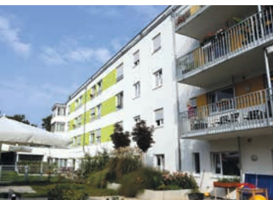
AWO-Seniorenzentrum „Im Kranichgarten“.
